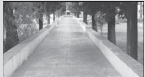
Arranjament del passeig central i lateral del cementiri amb pavistamp
